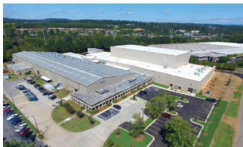
拠点全景（右奥が新設の自動倉庫）
