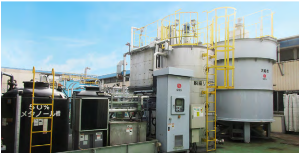
真岡工場 生物脱窒法排水処理施設
