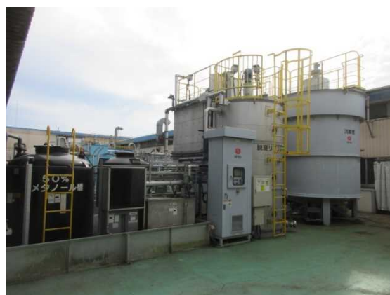
真岡工場 生物脱窒法排水処理施設
