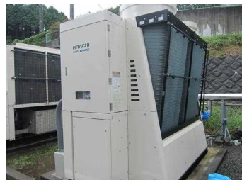
高効率モーター＋インバーター制御コンプレッサー、冷却チラー設備
