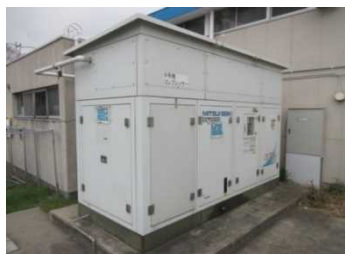
高効率モーター＋インバーター制御コンプレッサー、冷却チラー設備
