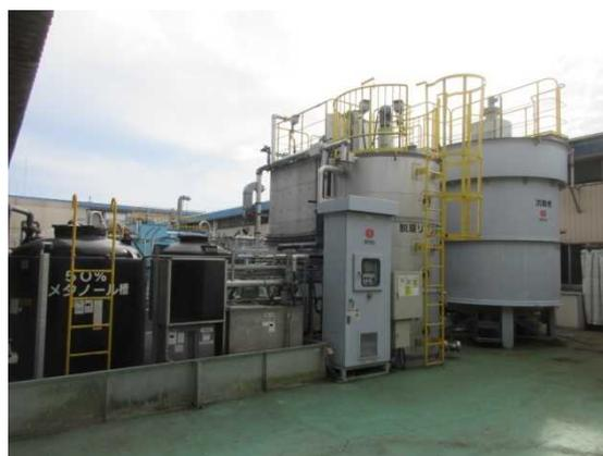
真岡工場 生物脱窒法排水処理施設
