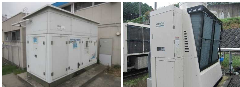
高効率モーター＋インバーター制御コンプレッサー、冷却チラー設備
