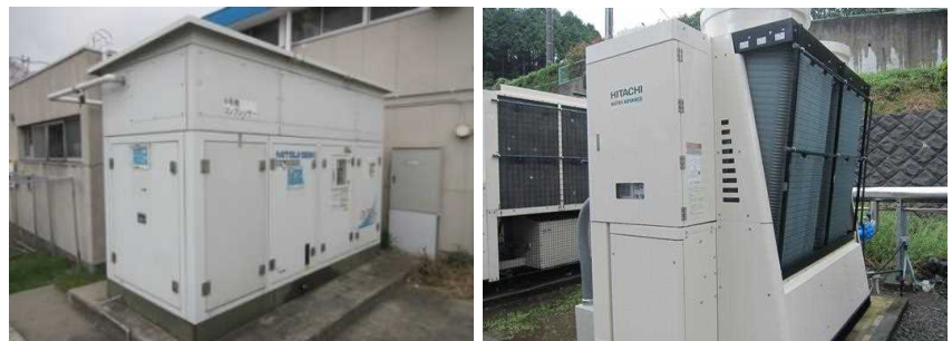
高効率モーター＋インバーター制御コンプレッサー、冷却チラー設備
