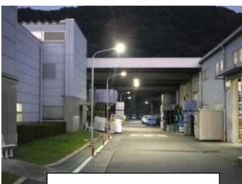
構内照明 LED 化
