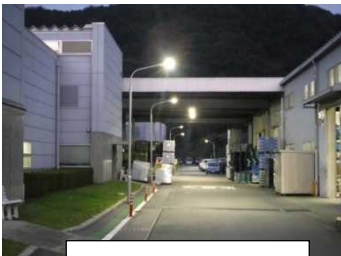
構内照明 LED 化
