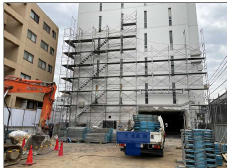
旧本社解体（横浜市岩井町）
