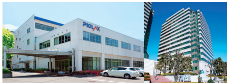
横浜テクニカルセンター（左）／一時移転先の横浜ビジネスパーク（右）
