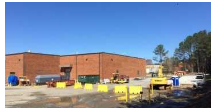
新熱処理炉建設中 2018年10月正式稼動予定
