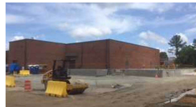
新熱処理炉建設現場 2018年5月
